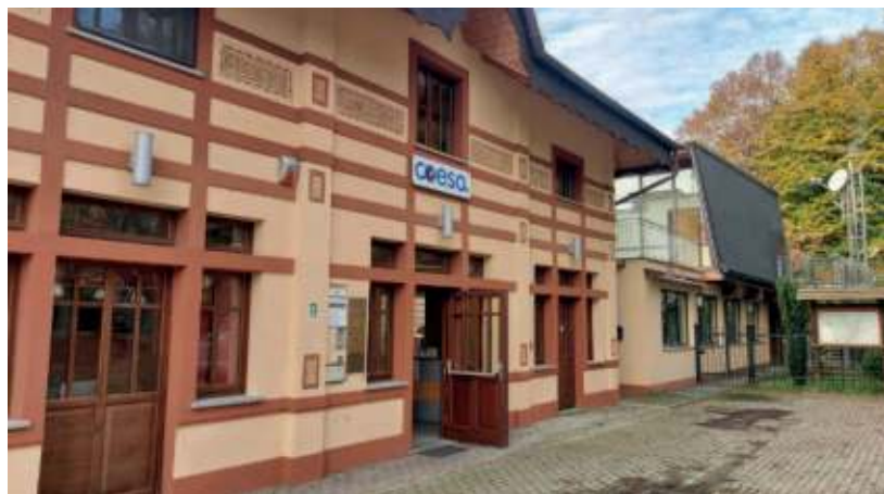
LA SEDE PRINCIPALE DI COESA SI TROVA IN UNA PALAZZINA LIBERTY SITUATA IN UNA DELLE PIAZZE CENTRALI DI PINEROLO. LA STRUTTURA, SU DUE PIANI, OSPITA UFFICI E UNA SALA CONFERENZE DA 70 POSTI
